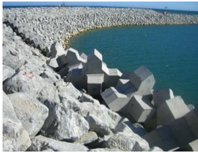
Figuur 47; Xbloc (Delta Marine Consultants, 2001).
