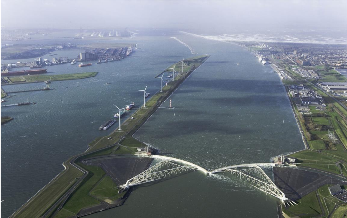
Figuur 11: Maeslantkering in gesloten en nog niet afgezonken toestand
