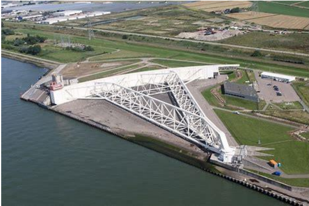
Figuur 10: Maeslantkering, open deur één zijde
