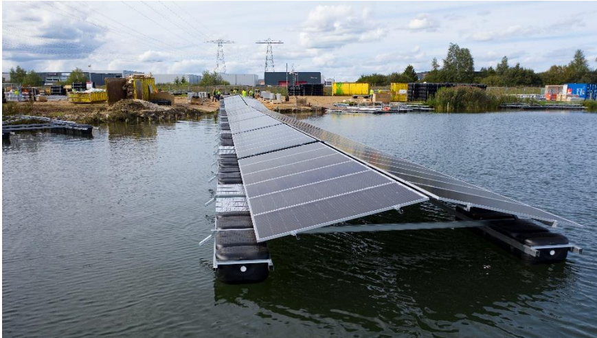
Figuur 18 De 'zonnebootjes' worden op het water gebracht. Bron: Foto gemaakt door Willem Biesheuvel van GroenLeven.
